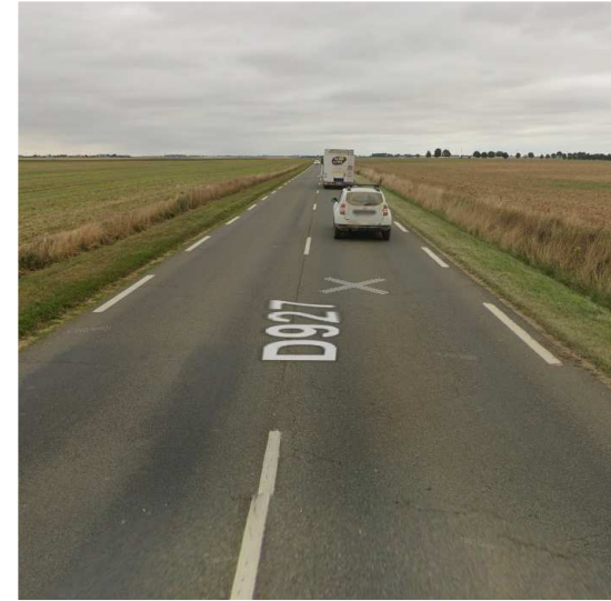
Aperçu de la RD927 entre Toury et le site du projet
